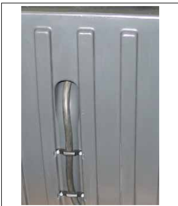
Fig. 6: Zugentlastung: Zugentlastungsschellen außen am Abscheider
